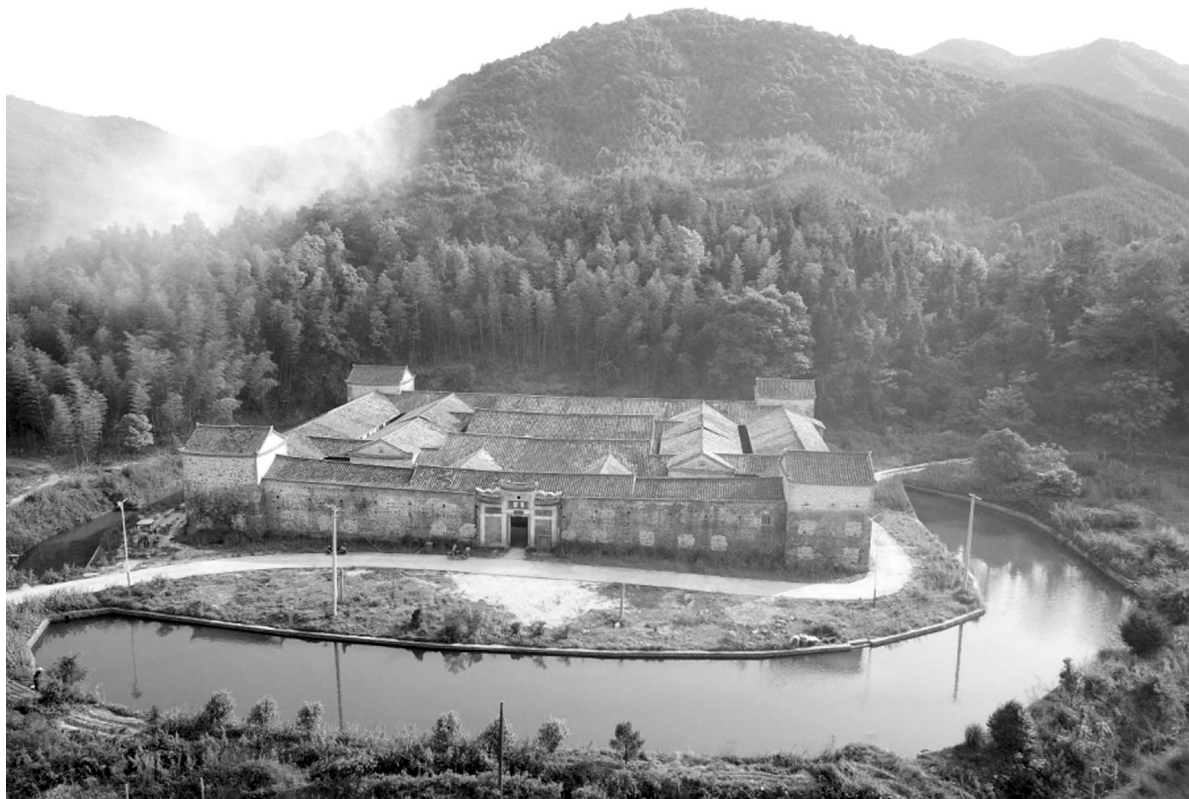
▲定南德盛围始建于清嘉庆十二年(1807年),系李氏延仁、延俊、辉煌、焜跃四兄弟所建。该围面宽60米,纵深48.6米,呈“回”字形平面构图,占地2916平方米,采用砖木、石木混合结构,是定南县客家围屋里极具代表性的璀璨明珠。佚名摄
